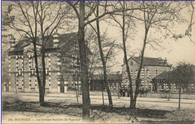
Le groupe scolaire de Pignoux
